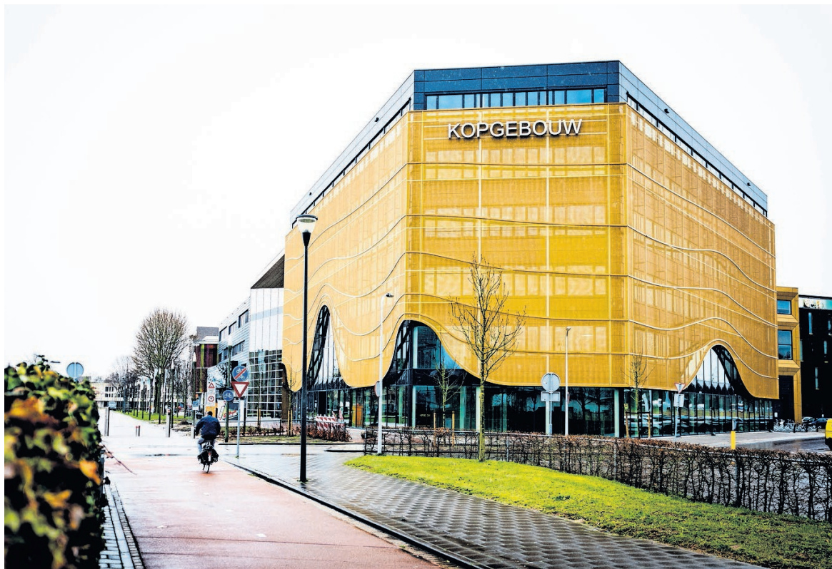
▲ De Dordrecht Academy komt in het Kopgebouw op het Leerpark. FOTOSQPHOTO
