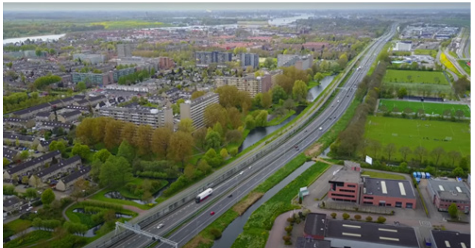
Verplaatsen A15 naast Betuwelijn
