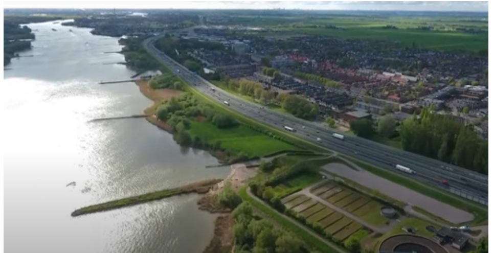
Verplaatsen A15 naast Betuwelijn
